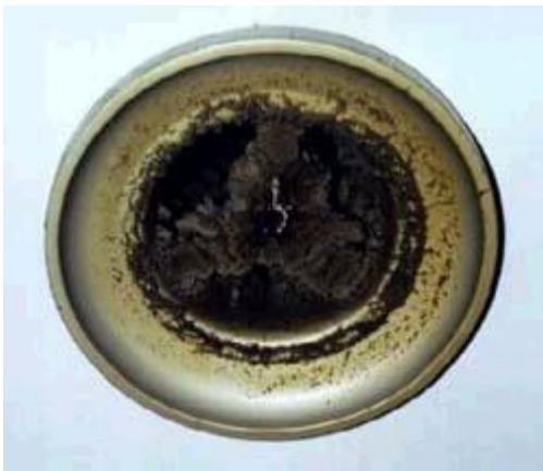
Útsogsventill fyrir hreinsun
