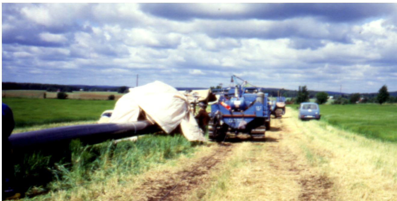
Unnið við suðu á röralögn.
