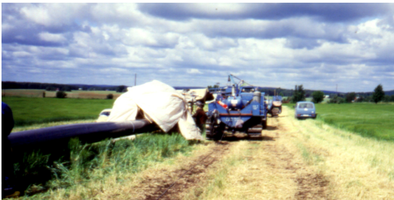
Unnið við suðu á röralögn.
