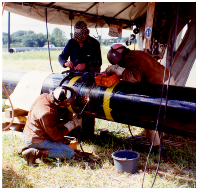
Dæmi um yfirbyggðan vinnustað.
