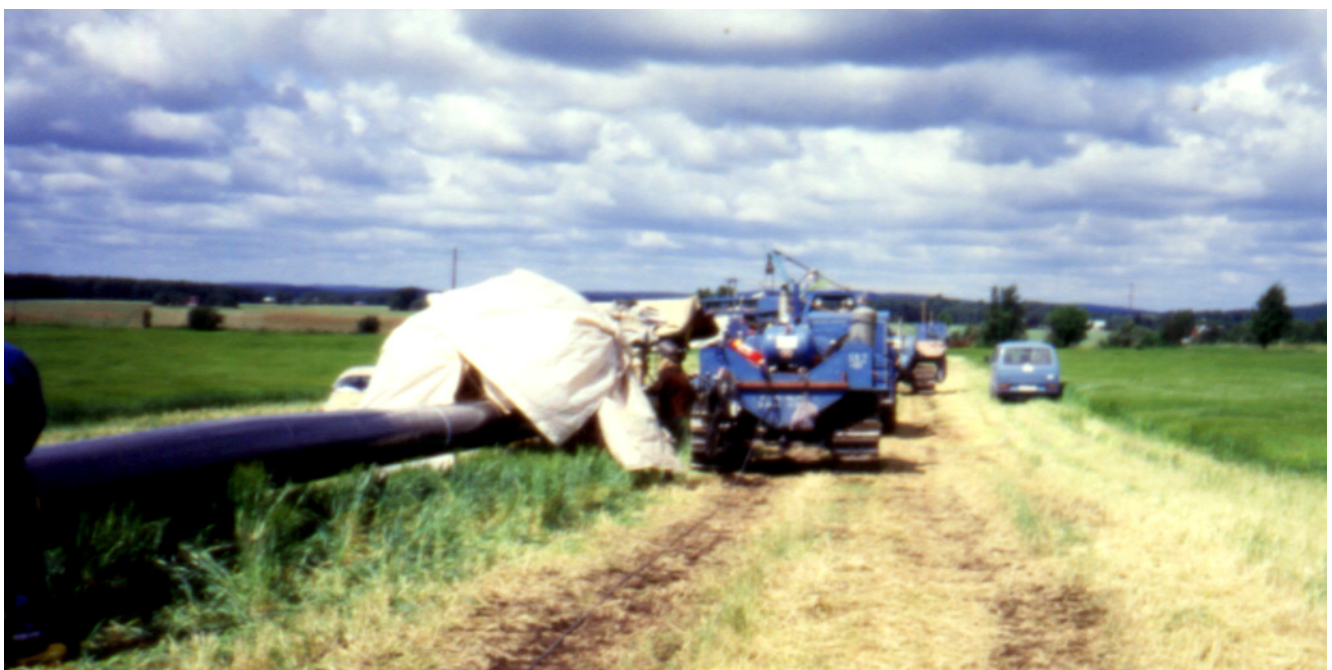
Unnið við suðu á röralögn.
