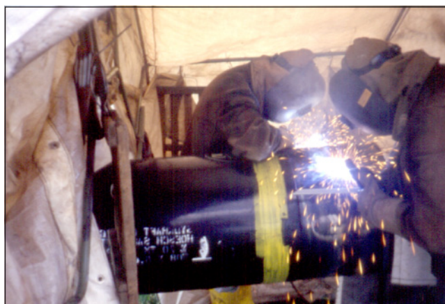
Fyrir rörasuðu er pinnasuðan ennþá besti
