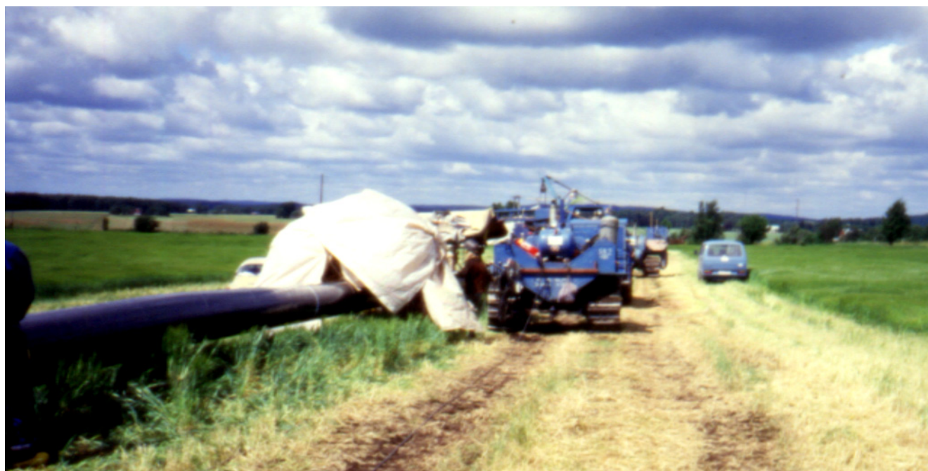
Unnið við suðu á röralögn.
