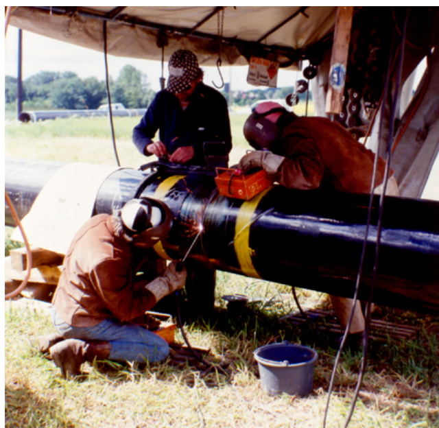
Dæmi um yfirbyggðan vinnustað.
